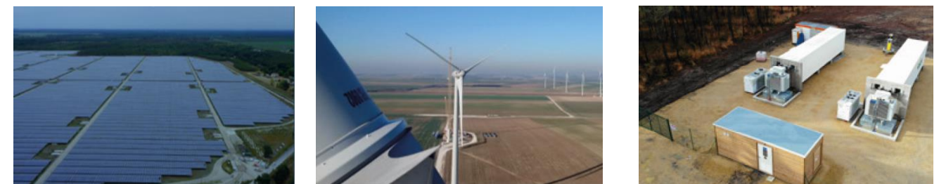
Figure 5 : De gauche à droite : Centrale Solaire de Cestas (300 MWc), Centrale Eolienne de Bussy-Lettrée (26 MW), et Azur Stockage (6 MW, 6MWh) (source : NEOEN, 2019)
